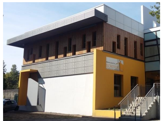
Les nouveaux locaux situés au bâtiment A32
