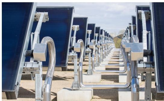
4 211 m<sup>2</sup> de panneaux solaires ont été installés pour produire l'énergie thermique nécessaire au préchauffage de l'eau d'appoint des chaudières alimentant le réseau de vapeur de la papeterie. **Plus de 1 000 tonnes de CO<sub>2</sub> sont évitées chaque année !**
